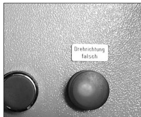
**Les modèles de type 1** sont équipés d'un affichage du sens de rotation. Il s'allume si le sens de rotation n'est pas le bon.
