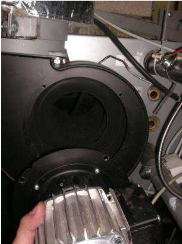
Abnehmen des Ventilators
