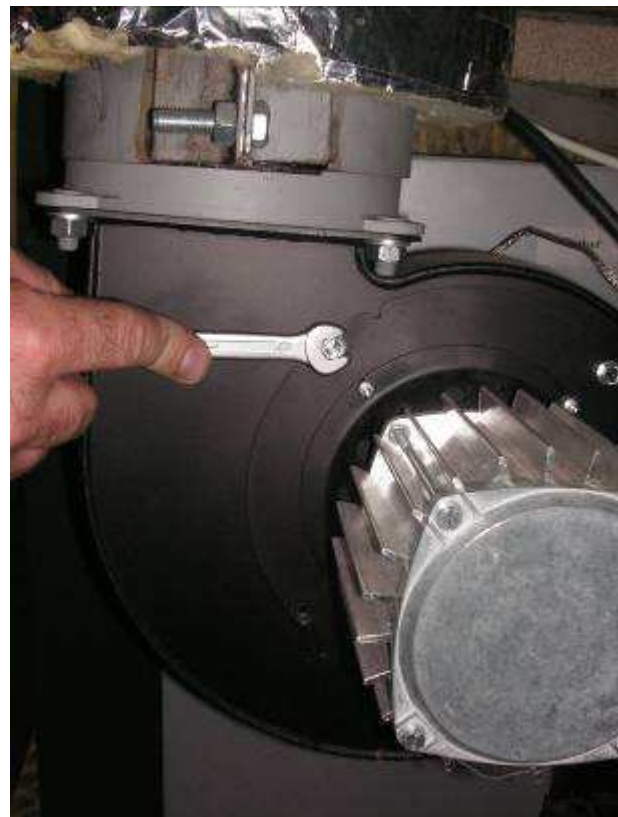
Öffnen der Halteschrauben des Ventilators
