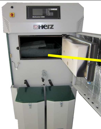
Ansicht – Brennkammer mit Abschlussstein Überprüfen Sie die ordnungsgemäße Reinigung des Rostes
