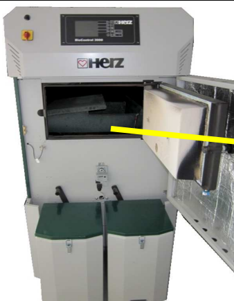
Vue – Foyer avec pierre réfractaire Vérifier le bon fonctionnement du nettoyage de la grille de combustion
