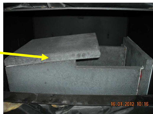
Vue – Foyer avec pierre réfractaire Vérifier le bon fonctionnement du nettoyage de la grille de combustion
