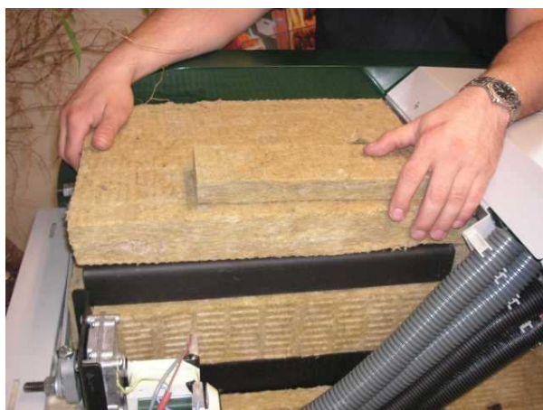
Enlever l'isolation thermique
