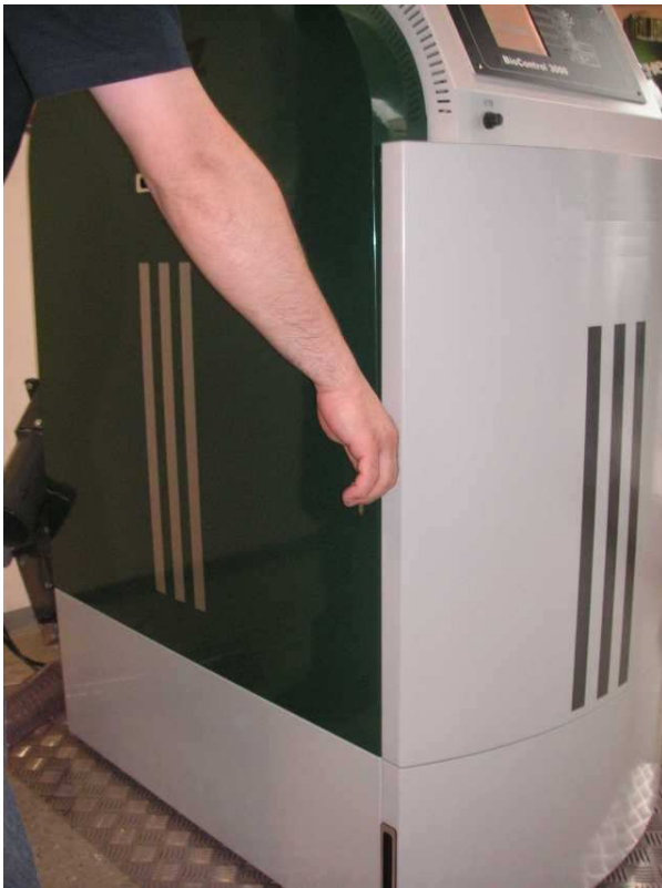
Déverrouillage de la face latérale avec la clé
