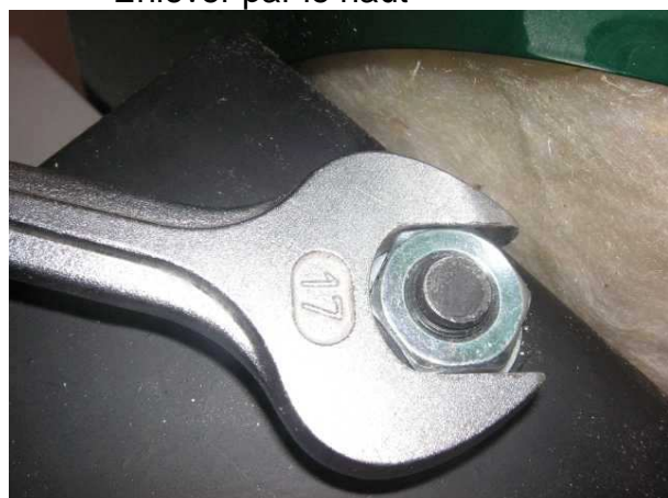
Ouvrir le couvercle du réceptacle de cendres volantes avec l'outil adapté (clé de 17)
