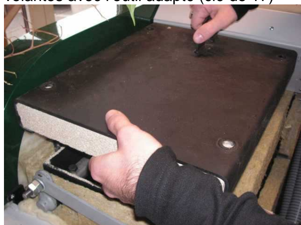
Ouvrir le couvercle du réceptacle de cendres volantes avec l'outil adapté (clé de 17)
