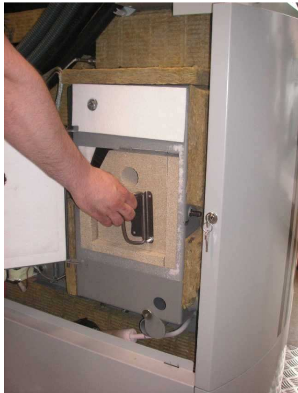
Démontage de l'isolation de la cellule de combustion
