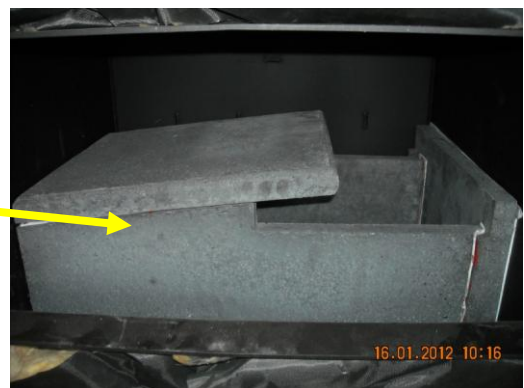
Ansicht – Brennkammer mit Abschlussstein Überprüfen Sie die ordnungsgemäße Reinigung des Rostes
