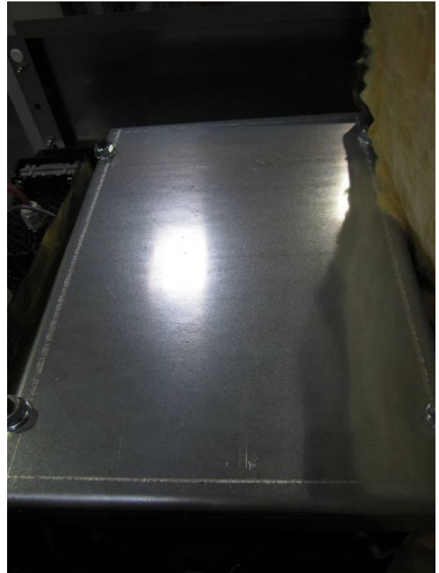
Flugaschendeckel entfernen
