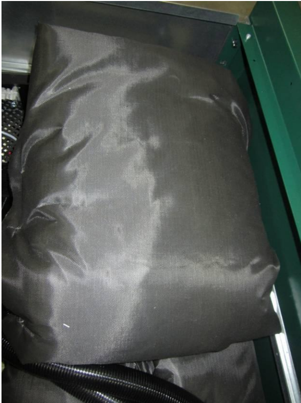
Entfernen der Wärmedämmung
