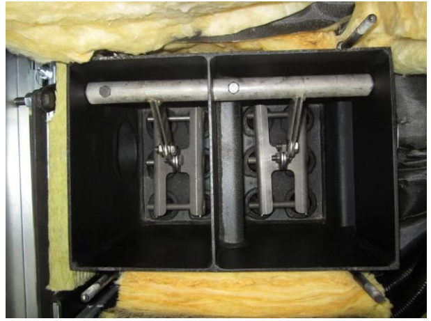
Ansicht auf Wärmetauscherreinigung
