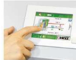
Les valeurs de la régulation de la chaudière peuvent être visualisées sur l'écran tactile. Il peut également servir d'interface pour modifier les paramètres (protégé par un code)
