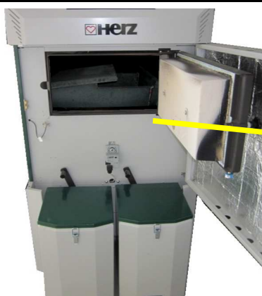
Vue – Foyer avec pierre réfractaire Vérifier le bon fonctionnement du nettoyage de la grille de combustion
