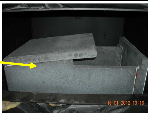
Vue – Foyer avec pierre réfractaire Vérifier le bon fonctionnement du nettoyage de la grille de combustion
