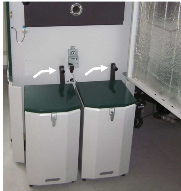
Tirer le levier de déverrouillage vers la droite pour détacher le cendrier
