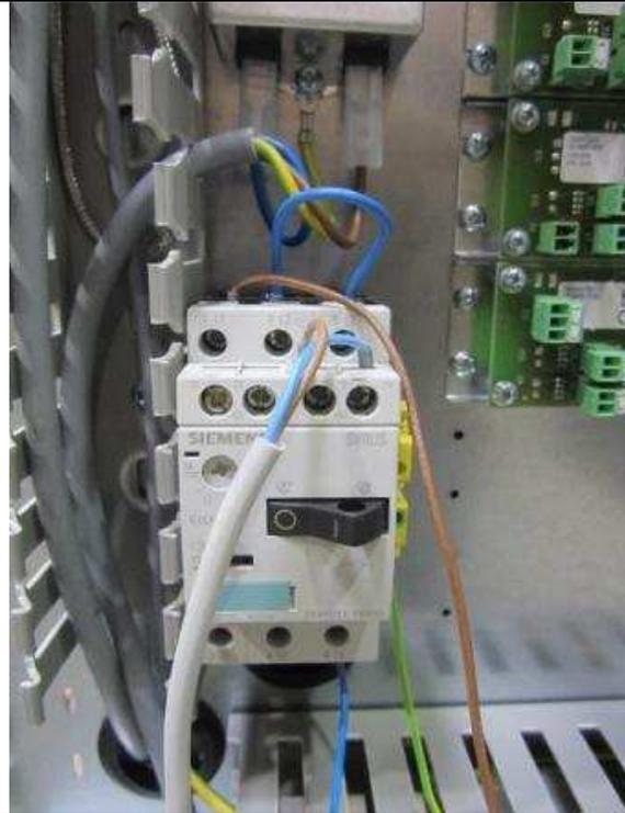
Montage de la protection moteur sur la barre
