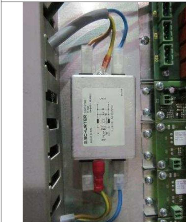
Montage / Vissage du filtre (raccordement selon le plan électrique du filtre d'alimentation)
