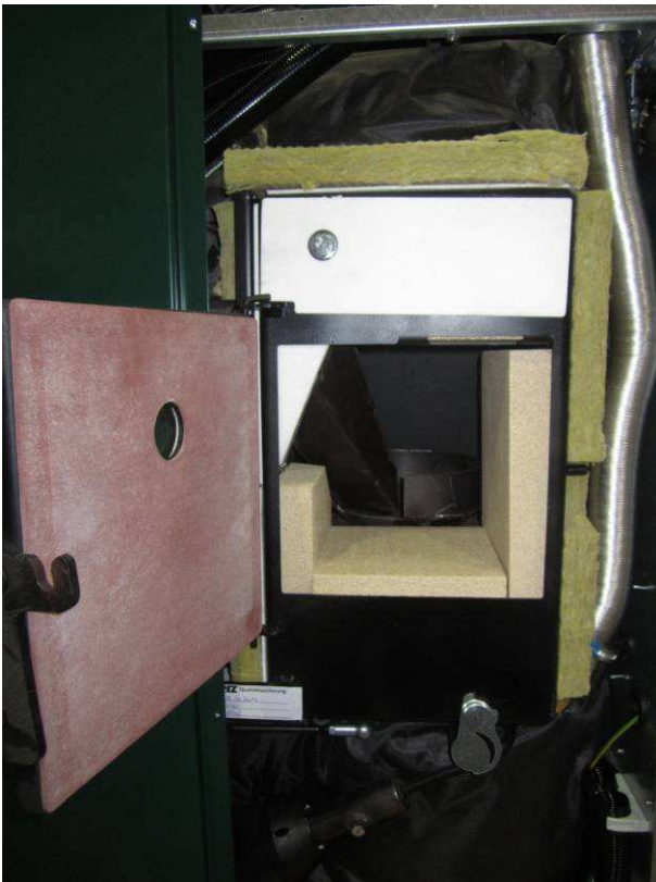
Démontage de l'isolation de la chambre de combustion
