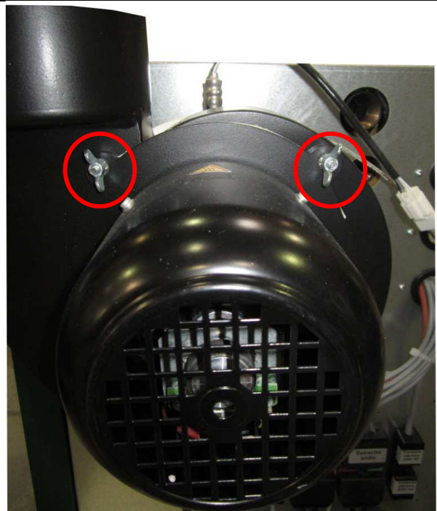
Enlevez les vis de fixation du ventilateur
