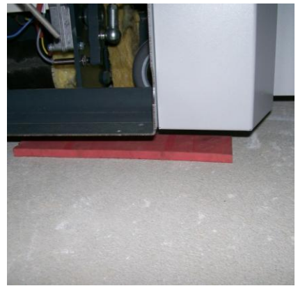
Placement du socle anti-vibratile! Lever légèrement la chaudière et placer les bandes anti-vibratile en dessous (option).
