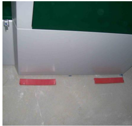
Placement du socle anti-vibratile! Lever légèrement la chaudière et placer les bandes anti-vibratile en dessous (option).
