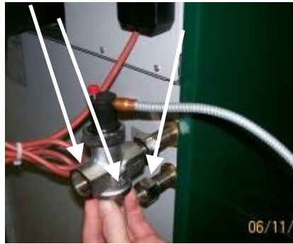
Raccordement à l'évacuation Soupape de décharge thermique (accessoire Sté HERZ)
