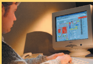
Possibilité de télé-surveillance et de télé-maintenance
