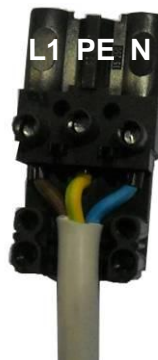
Raccord fixé sur la chaudière et avec
