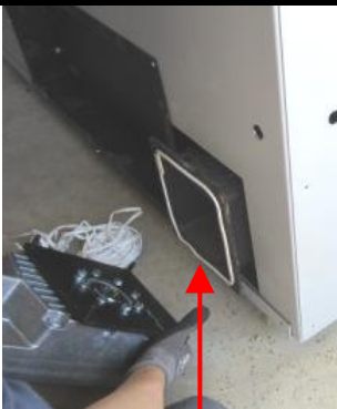
Montage du joint pour le moteur d'extraction des cendres volatiles. Resserrer les vis.
