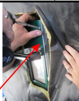
Montage du couvercle de protection de la vitre
