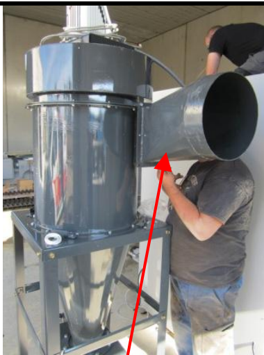
Monter le joint et la bride.
