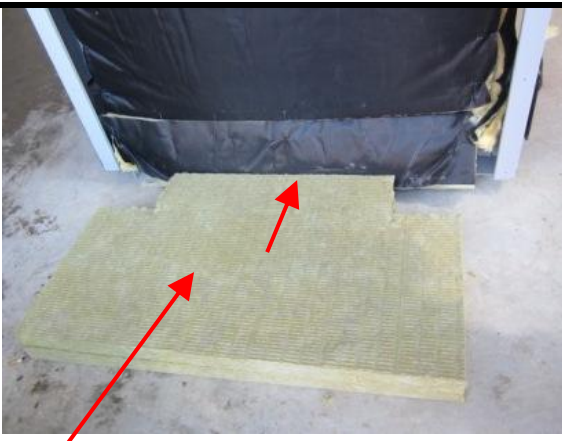
Isolation pour le module échangeurs – découper la partie inférieure (couper des coins d'environ 10cm*10cm) et la positionner sous le module.
