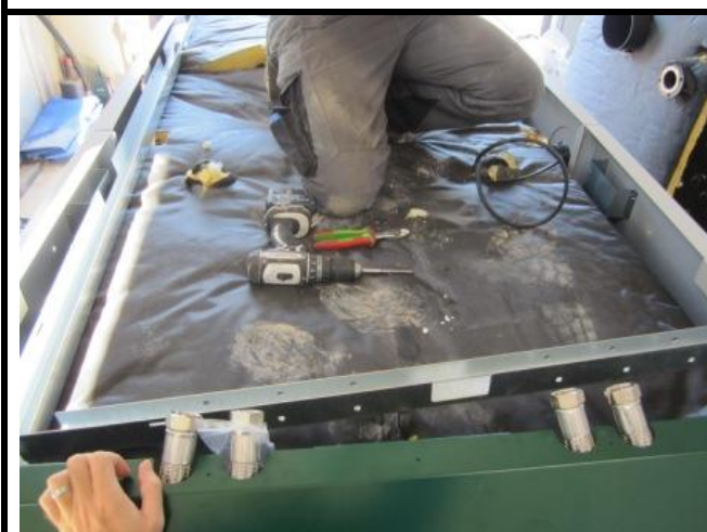
Montage du conduit de câbles sur la partie supérieure de la chaudière.
