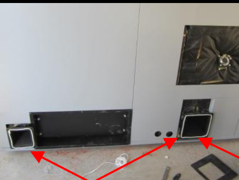
Montage des joints de l'autre côté
