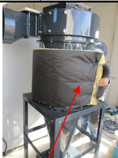
Isoler le filtre cyclone et attacher avec des fixations.
