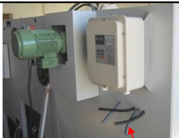
Percer et passer les tubes de protection de câbles.
