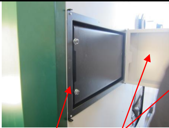
Montage du cadre de porte et de l'habillage de porte foyer des 2 côtés
