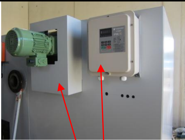
Montage der Verkleidung für WTR-Motor und Montage der Saugzuggebläsesteuerung.
