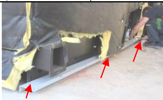
Die Halbleche für die Verkleidungen werden an 3 Stellen befestigt.
