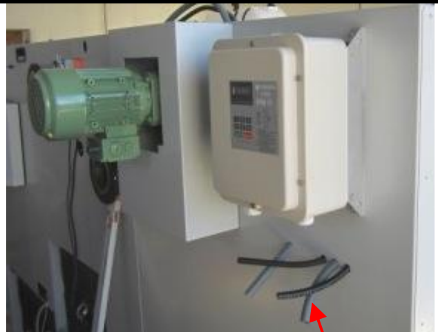
Bohren und verlegen der Kabelschutzschläuche.
