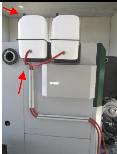
Anschließen und verlegen der Schläuche vom Löschwasserbehälter zum Einschub.
