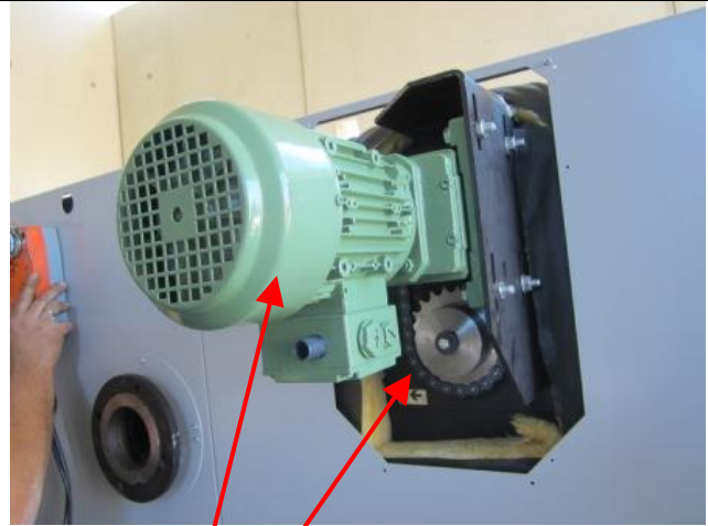
Montage Motor für Wärmetauscherreinigung und Antriebskette spannen(+5mm). Lager schmieren.
