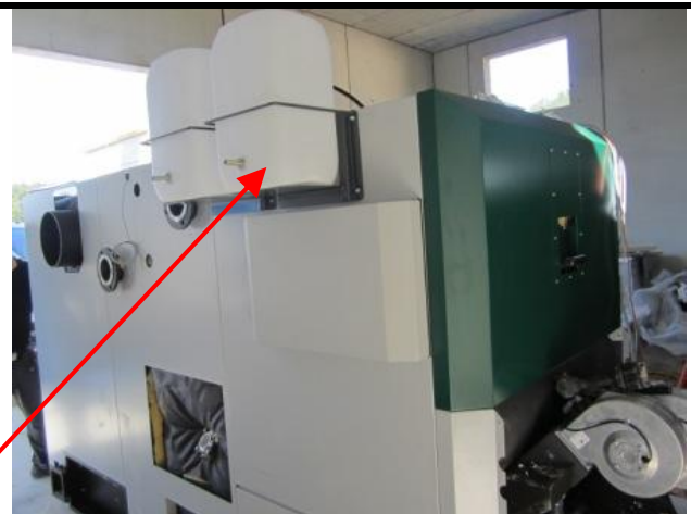
Montage der Halterungen für die Löschwasserbehälter je nach Platzbedarf (meist gegenüberliegende Seite der BioControl-Steuerung).
