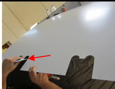
Nachdem alle Kabel an der Kesseloberseite in den Kabelkanälen verlegt worden sind, können die Kesselverkleidungen oben montiert werden.
