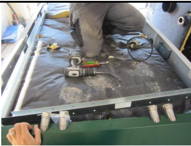
Montage der Kabelkanäle auf der Oberseite des Kessels.
