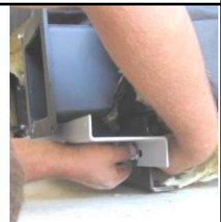
Schrauben vorerst nur handfest anschrauben.
