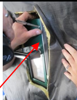
Montage der Abdeckung Stein-Schieber Schauloch
