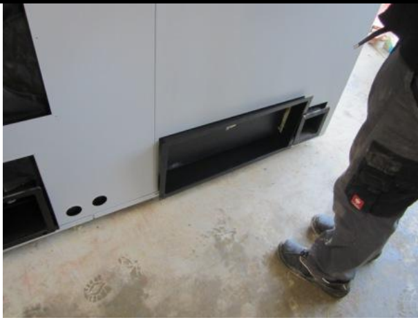
Montage der Verkleidung FAD Einsatz
