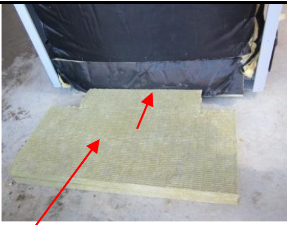
Isolierung für Wärmetauschermodul - Unterseite zuschneiden (Ecken ca.10x10cm ausschneiden) und unter WT-Modul positionieren.
