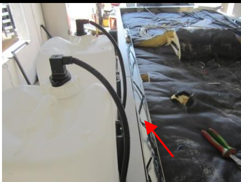
Nachdem alle Kabel an der Kesseloberseite in den Kabelkanälen verlegt worden sind, können die Kesselverkleidungen oben montiert werden.
