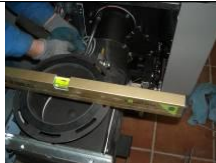
Mittels einer Wasserwaage kann die Einzugschnecke ausgerichtet werden.
