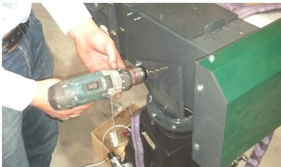
Fixer la tête de transfert, percer un sixième trou de chaque côté. Elle doit être fixée avec les glissières, des bagues d'arrêt, des écrous et des vis M6x16.
