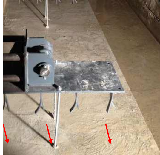
Image 3.11: Positionnement des platines d'ancrage des vérins
