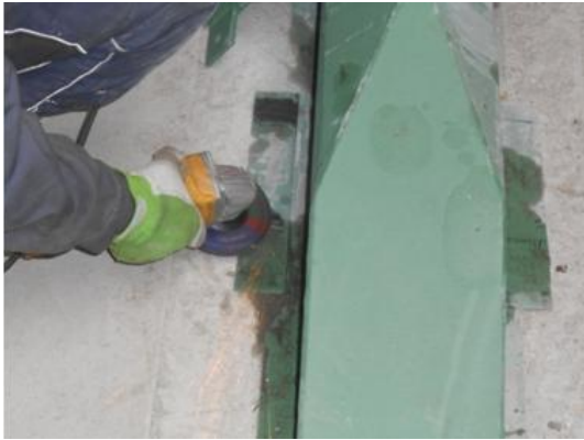
Image 3.36: Abrasez de l'acier pour le soudage
