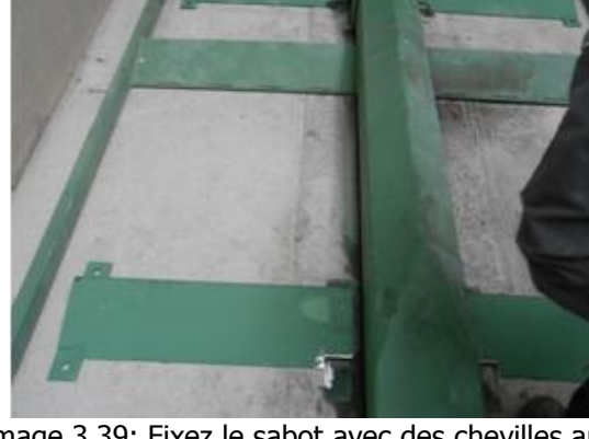
Image 3.39: Fixez le sabot avec des chevilles aux emplacements marqués
