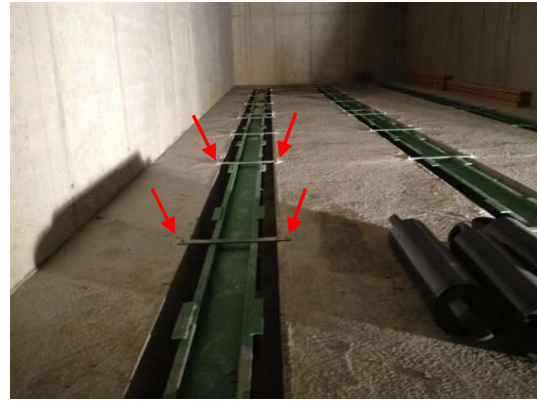
Image 3.6: Ancrer les éléments restants de structure
