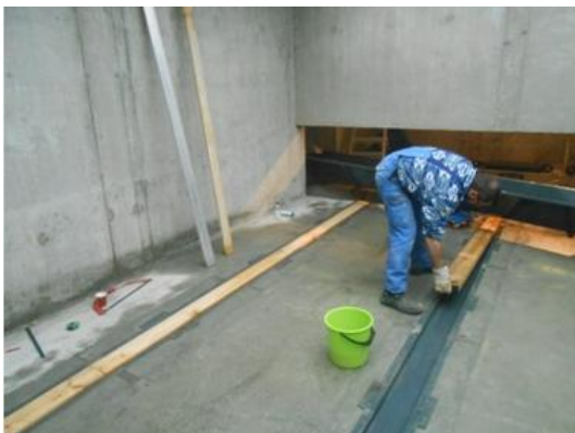
Image 3.15: Insérez le bois dans la structure
