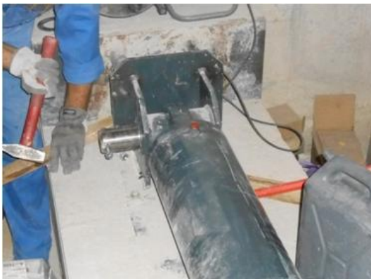
Image 3.30: Fixez le vérin sur sa fixation avec des chevilles
