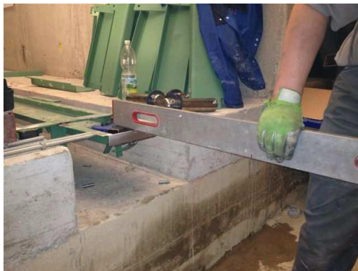
Image 3.2: Alignement du support cylindre avec la structure
