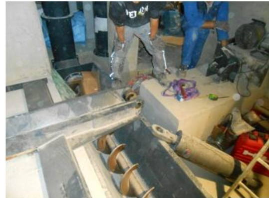
Image 3.29: Alignez les échelles avec la longueur des vérins
