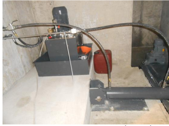
Image 3.4: Platine d'ancrage des vérins bétonnée
