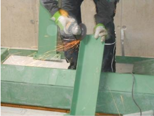
Image 3.34: Abrasez les sabots pour le soudage
