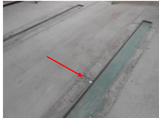
Image 3.10: Structure entièrement assemblée
