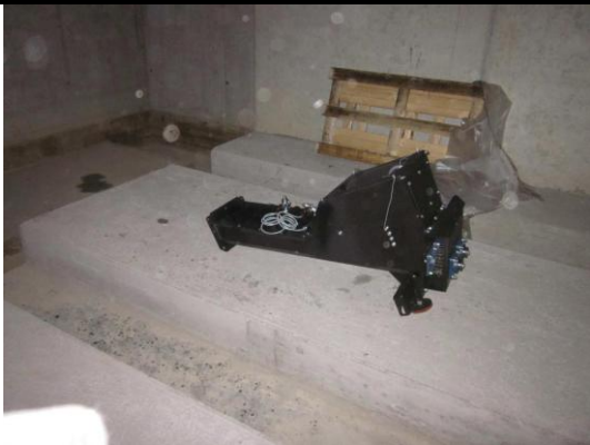
Image 3.3: Réserveation une fois terminée et bétonnée
