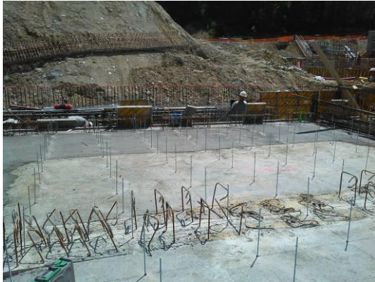
Image 3.14: Tiges filetées dans le socle béton
