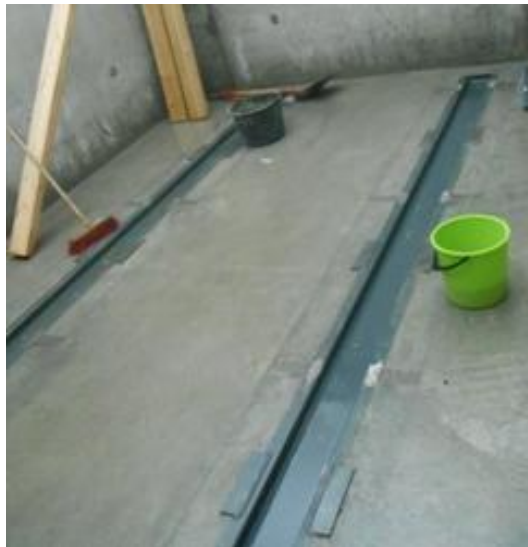
Image 3.14: Nettoyage de la structure
