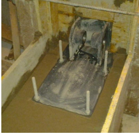
Image 3.13: Platines d'ancrage des vérins bétonnées
