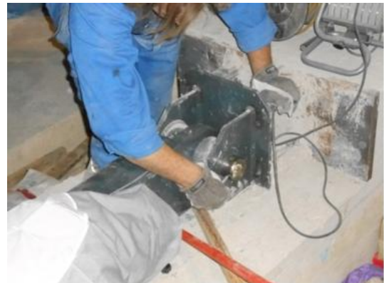
Image 3.31: Fixez les chevilles avec des vis et des écrous de sécurité
