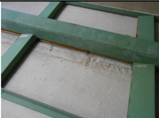
Image 3.26: Positionnement des échelles avant le montage des vérins
