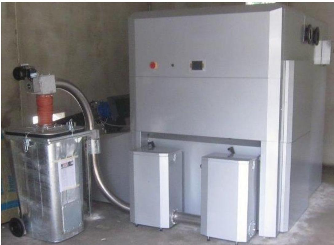
Fertig montierter Kessel mit zentraler Aschenaustragung.
