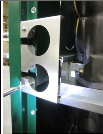
Montage der zwei Kabeldurchführungen links und rechts bei der oberen Rückwandabdeckung. Montage der unteren und der mittleren Rückwandabdeckung.
