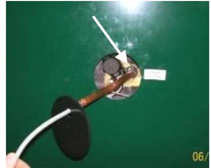
Kapillarrohr in Tauchhülse
