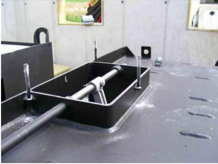
Dévissez les 3 écrous et enlevez le couvercle du clapet Bypass
