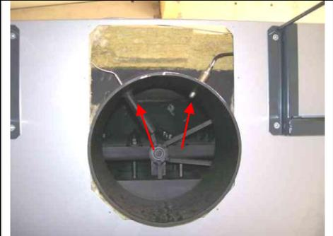
Vissez la sonde Lambda et la sonde de température des fumées (les 2/3 de cette dernière doivent rentrer à l'intérieur du conduit)
