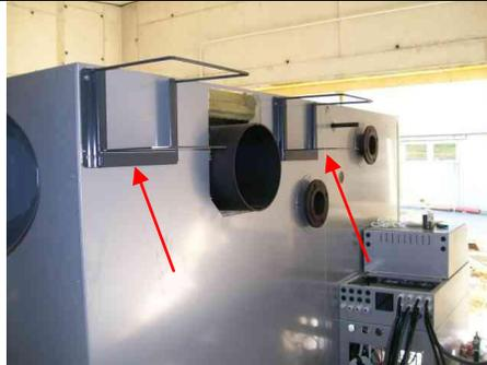
Montez les supports pour les bidons de sprinkler comme le permet l'installation (dans ce cas sur le panneaux latéral de la chaudière)
