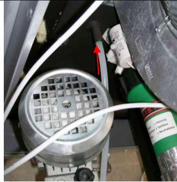
Fixer le tuyau du capteur de dépression sous al réserve intermédiaire
