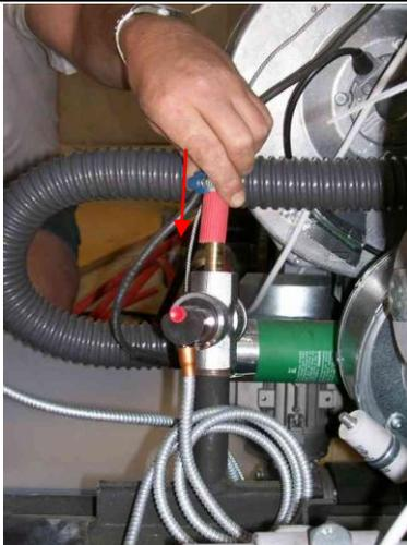
Monter le tuyau sur les soupapes des sprinkler avec le collier de serrage
