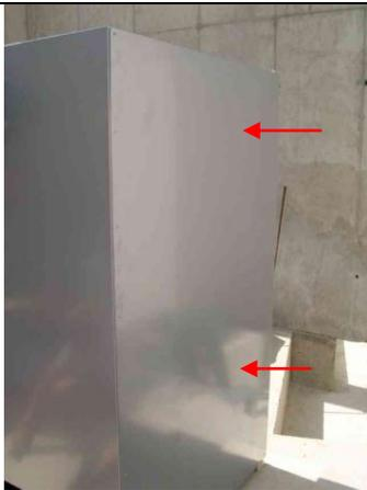
Vissez l'habillage du côté arrière avec des vis autoperforantes
