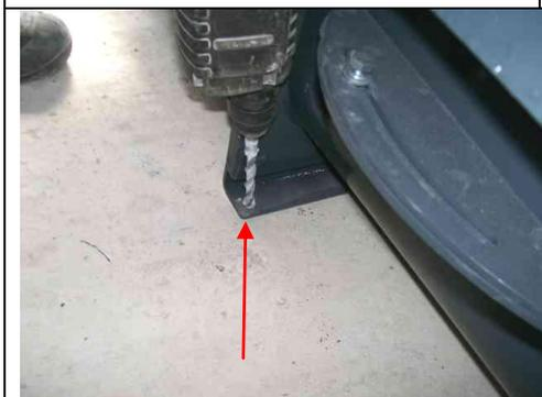
Percez 2 trous dans le sol au niveau du pied de la vis d'extraction ...Placez les chevilles et vissez le pied au sol.
