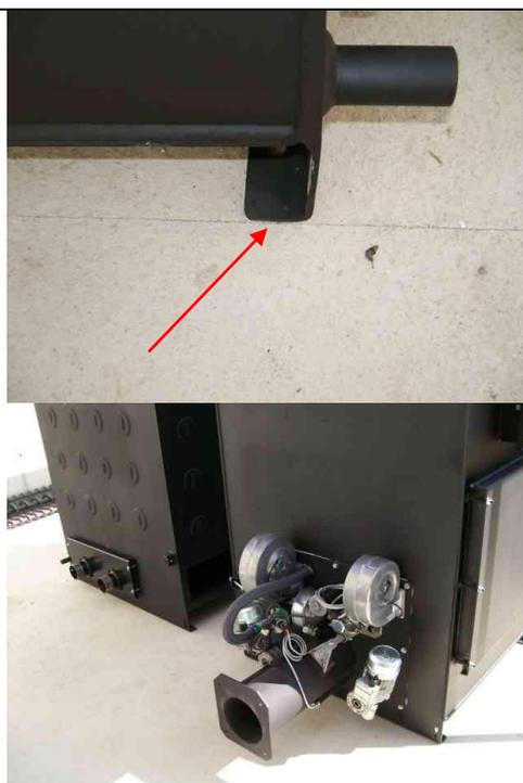
Placez la chaudière et l'échangeur sur les repères au sol conformément au plan!
