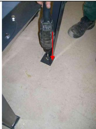
Percer des trous, positionner les chevilles et visser le cyclone au sol
