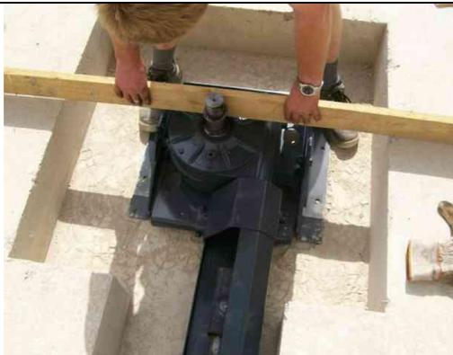
Contrôlez que la hauteur du canal de la vis correspond au plan
