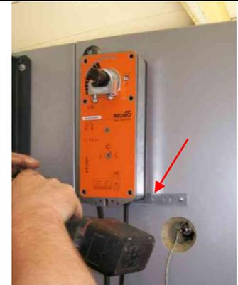
Monter le moteur du bypass. Serre le moteur sur l'arbre et fixer la barre en métal du support moteur.
