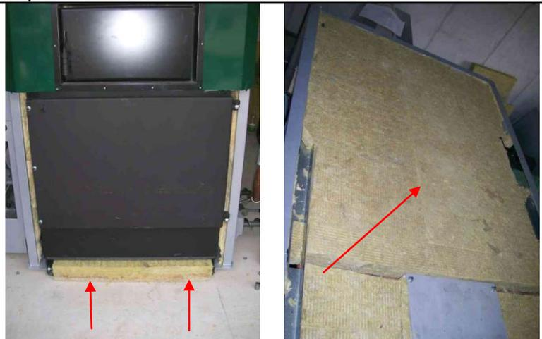
Isolez la partie inférieure de la chaudière et la partie supérieure de l'échangeur thermique
