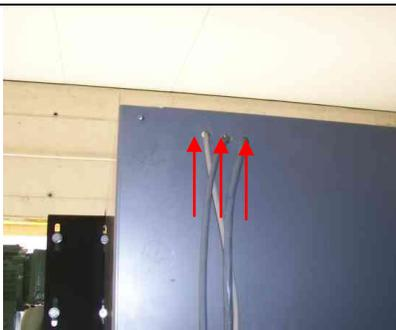
Si cela est possible percer des trous dans le revêtement pour le passage des câbles du boîtier électrique
