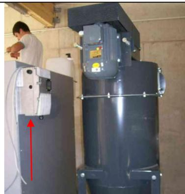
Vissez le variateur de fréquence sur le carénage
