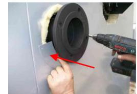
Assemblez les 2 habillages et appuyez les contre la chaudière. Vissez les habillages sur le bord inférieur avec des vis auto-perforantes. Ensuite vissez les deux demi-lunes avec des vis auto-perforantes
