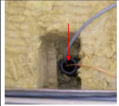
Insérer la sonde dans le doigt de gant prévu à cet effet. Toujours mettre tube pré-établi. Toujours mettre celle-ci a coté du coté départ chauffage.
