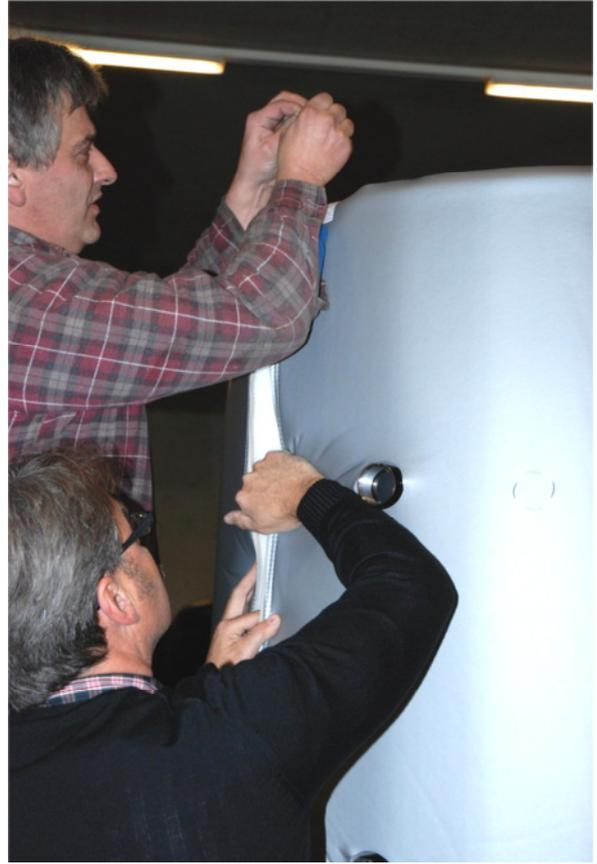
Accrocher le zip en haut et, tandis que la deuxième personne tient les pièces, tirer vers le bas morceau par morceau. Il peut être encore nécessaire d'envelopper l'isolation par presser et frapper avec la main bien tendu sur l'accumulateur.
