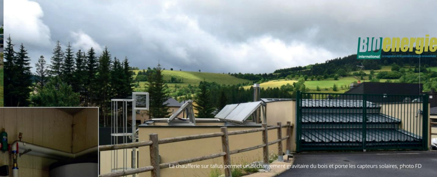
La chaufferie sur tallus permet un déchargement gravitaire du bois et porte les capteurs solaires, photo FD
